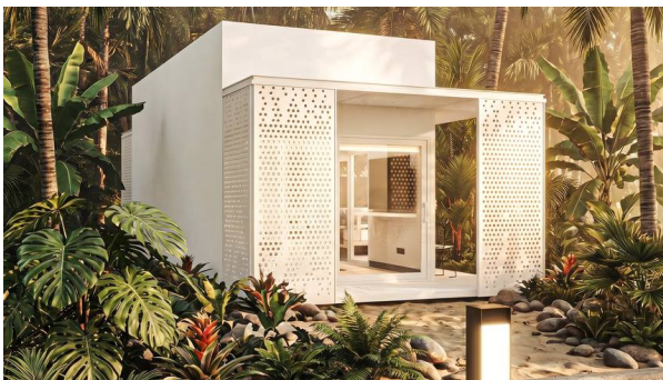
fachada móvil en lámina perforada abierta: sombra sobre la fachada acristalada sin cerrar la vista.
