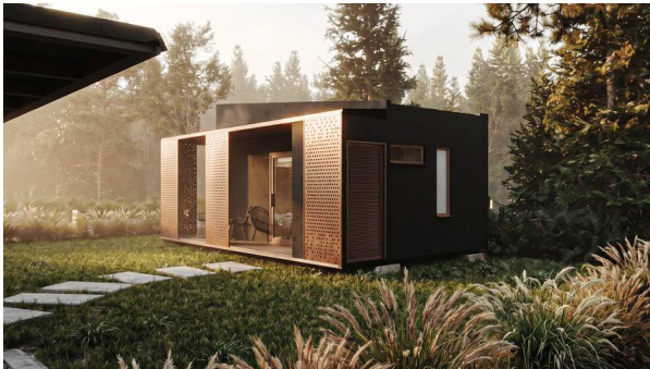
Fachada oscura y cerramiento cerrado. La unidad se eleva y queda ventilada por debajo.
