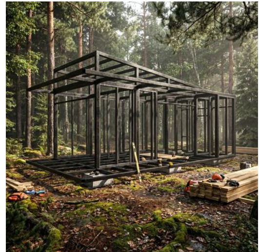
Pórtico armado sobre zapatas, antes de cerrar la envolvente.
