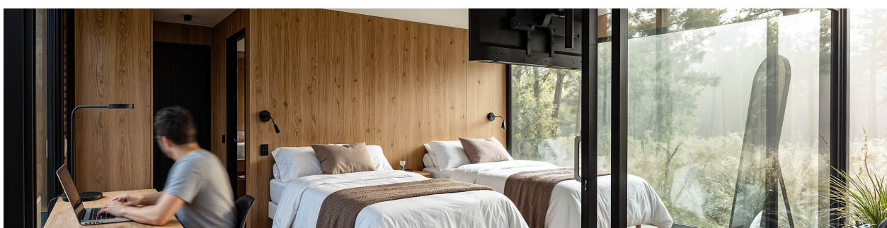
Los mismos acabados, instalados: wall panel en muros y cieloraso, piso de núcleo rígido y carpintería en aluminio.
